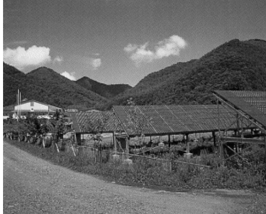
図表 6-6 葛巻中学校太陽光発電設置状況(葛巻町 HP より)
