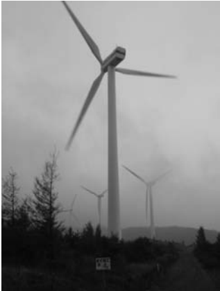
図表 6-5 風力発電設置状況
