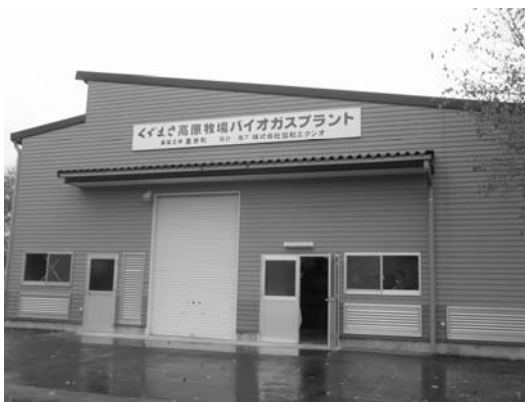
図表 6-3 バイオガスプラント外観
